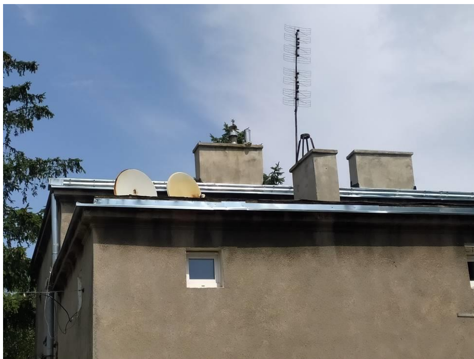
Dach po remoncie
