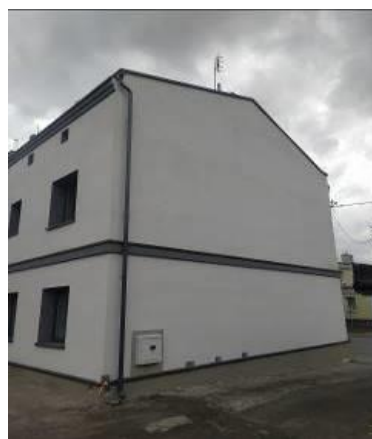
Budynek przy ul. Aptecznej 17
