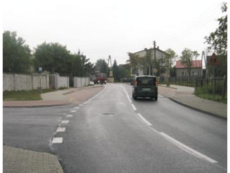
Ulica Słowackiego z nową nawierzchnią. Myszków-Nowa Wieś
