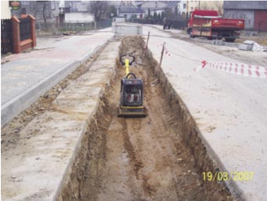
Droga w trakcie remontu
